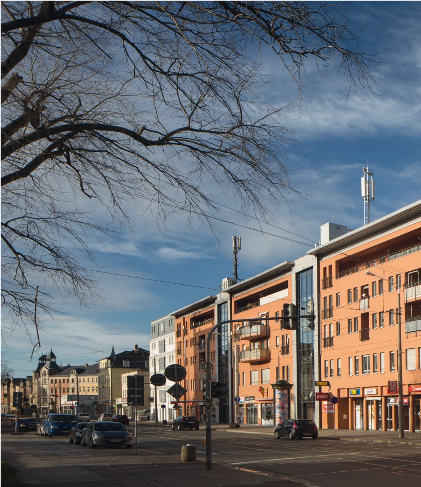
Exemplarisch: ZBI PROFESSIONAL 9, Dresden, Kesselsdorfer Straße
